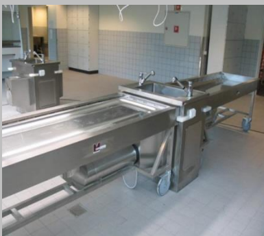
Studenten-Präpariertisch mit Transfer-Arbeitsfläche und Absaugung nach unten (Beispiel: Anatomie Trondheim / Norwegen)
