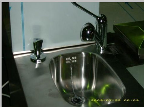
Spüle mit 25 mm Radius. Links : Ventil für Ringspülsystem unterhalb der Arbeitsfläche
