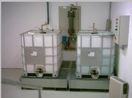
Zentrale Formalin-Ver- und Entsorgungsanlage mit je einem 600 Liter Behälter für Frisch - und Alt-Formalin
