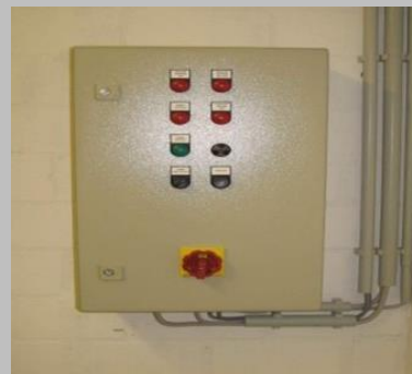
Steuerschrank für Ver- und Entsorgungseinheit
